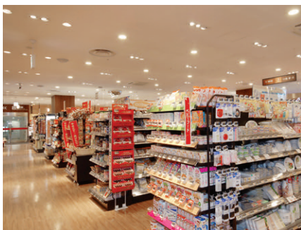
売場の中央横動線上にシステムダウンライト2灯用を、Gondola間には3灯用を使用
